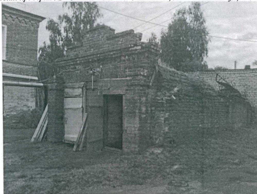
Объект проверки № 4 Здание склада г. Ульяновск, Льва Толстого ул, д. 37/110
