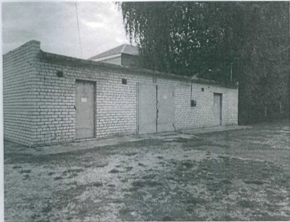
Объект проверки № 6 Здание склада г. Ульяновск, Льва Толстого ул, д. 37/110
